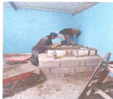
Foto 2: INSTALACIÓN DE ESTUFA RURAL (COMPLETA) INCLUYE CHIMINEA Y PLANCHA DE METAL
