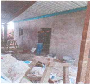
Foto 5: SUSTITUCIÓN DE PUERTA
