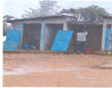
Foto 4: SERVICIO SANITARIO Y SUS ACCESORIOS
