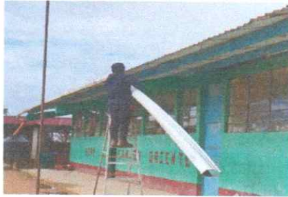
Foto 3: CANALES Y BAJADAS DE AGUA PLUVIAL
